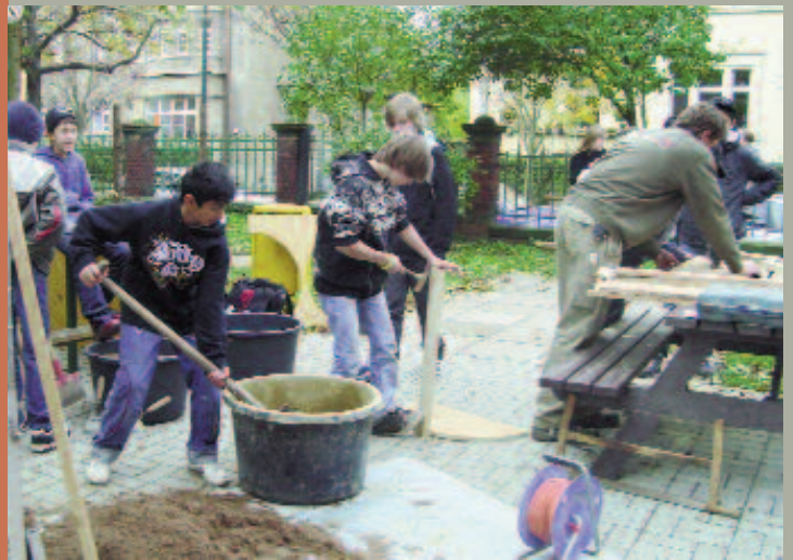
Voller Tatendrang: Während die einen ein Gemisch aus Lehm, Stroh und Sand für den Bau eines Lehmbackofens vorbereiten, pressen die anderen frischen Apfelsaft
